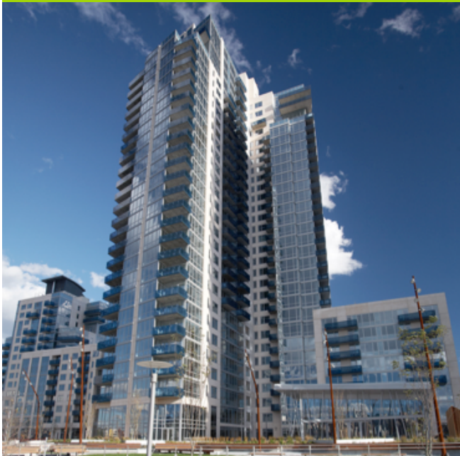
The Edge Condominium
